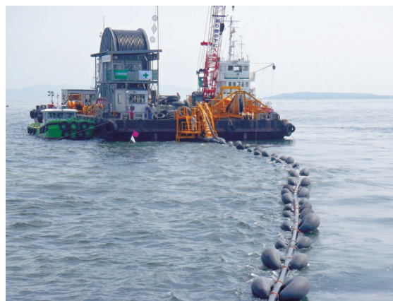
図2. 海底送水管 布設状況（愛知県 南知多町）
